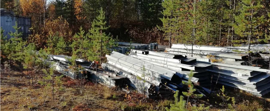
Kuva 7. Teollisuushallin osia, jotka on määrätty poistettavaksi 31.12.2021 mennessä.
