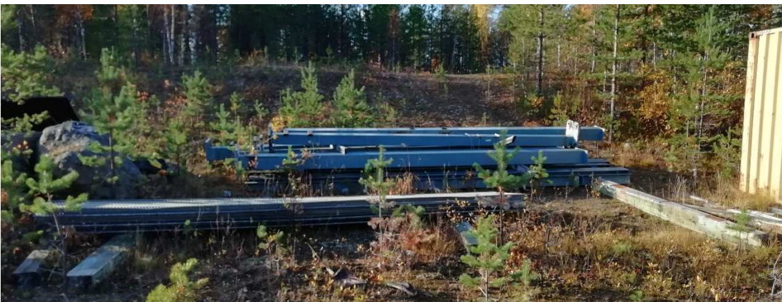
Kuva 6. Teollisuushallin osia, jotka on määrätty poistettavaksi 31.12.2021 mennessä.
