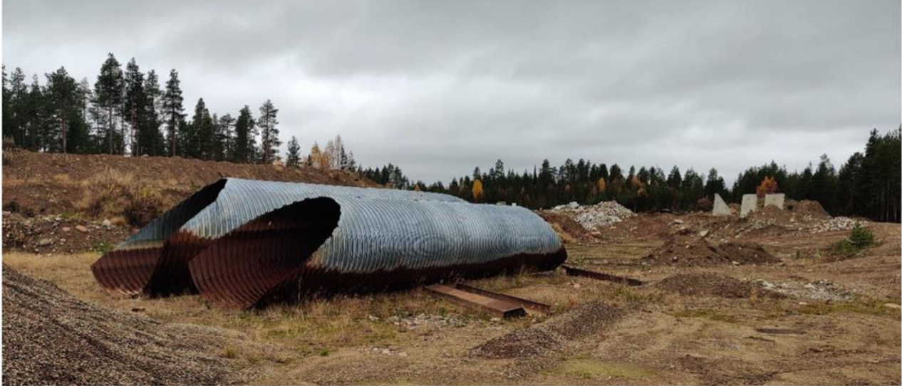
(Kuva 9. Putkisillat ja betonielementit, jotka on määrätty poistettavaksi 31.8.2021 mennessä.) Kuvassa putkisilloja, larseenin pontteja ja betonielementtejä. Mikään näistä ei ole jätettä.
