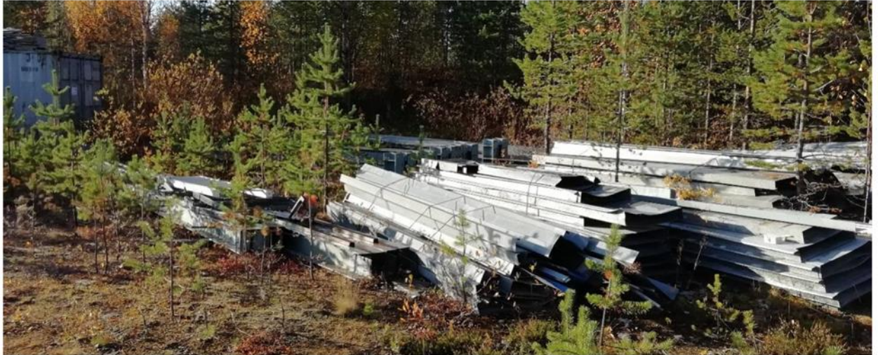
(Kuva 7. Teollisuushallin osia, jotka on määrätty poistettavaksi 31.12.2021 mennessä.) Kuvassa seinäpeltejä, nosturiradan palkkeja ja runkopalkkeja. Mikään näistä ei ole jätettä.
