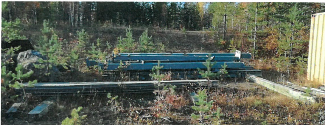
Kuva 6. Teollisuushallin osia, jotka on määrätty poistettavaksi 31.12.2021 mennessä.
