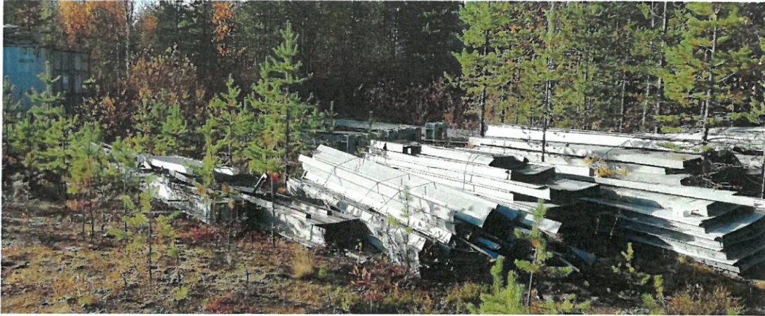
Kuva 7. Teollisuushallin osia, jotka on määrätty poistettavaksi 31.12.2021 mennessä.
