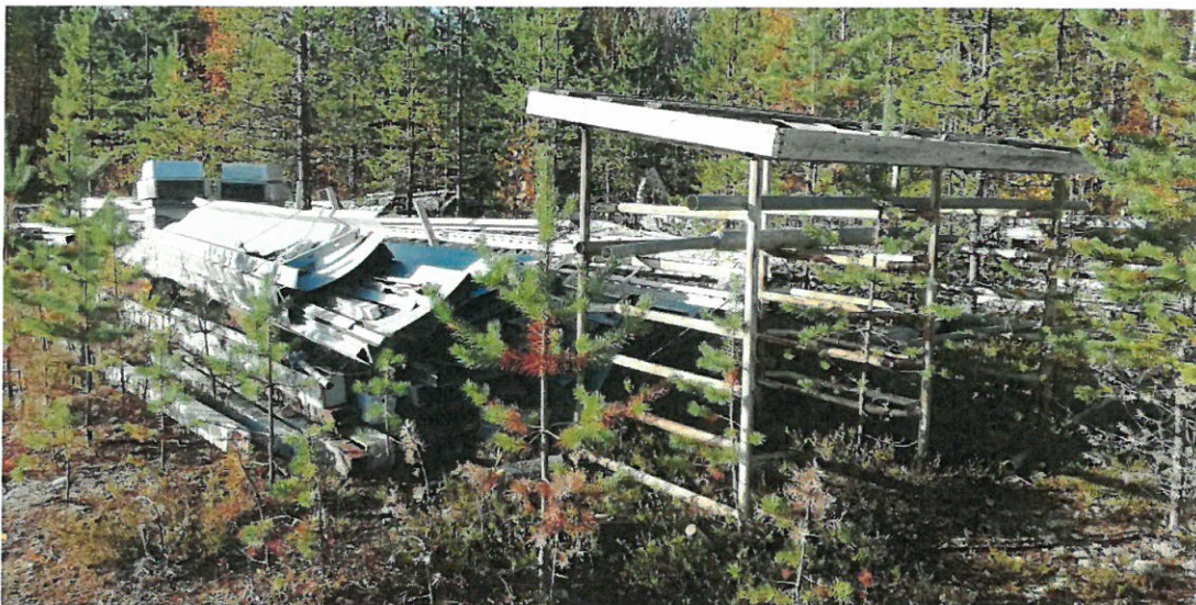
Kuva 8. Teollisuushallin osia, jotka on määrätty poistettavaksi 31.12.2021 mennessä.
