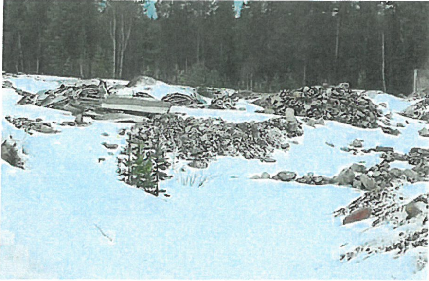
Kuva 8. Osaksi murskattua betonijätettä, sekä maa-aineksia.
