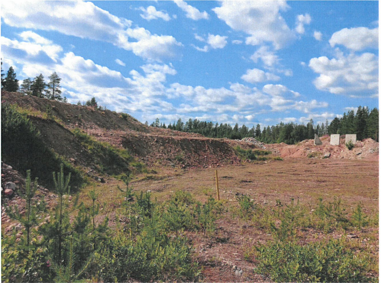
Kuva 1. Maa-ainesalueen luiskaamatonta reunaa. Taustalla alueelle varastoituja jätteitä.
