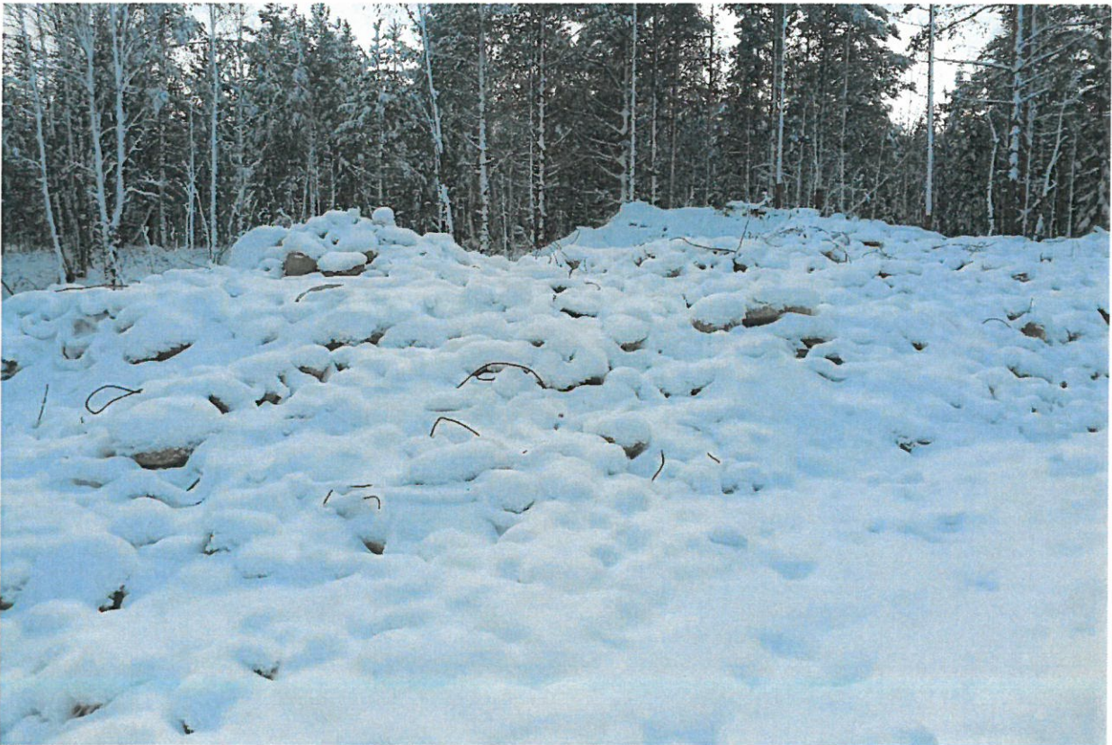
Kuva 1. Lumen peittämää purkubetonia ja rautoja kiinteistöllä 320-412-4-4.
