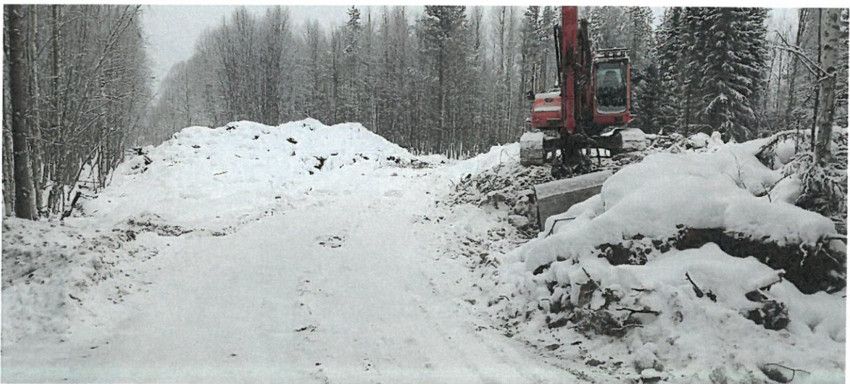
Kuva 1. Lumen peittämää purkubetonia ja rautoja kiinteistöllä 320-412-4-4.
