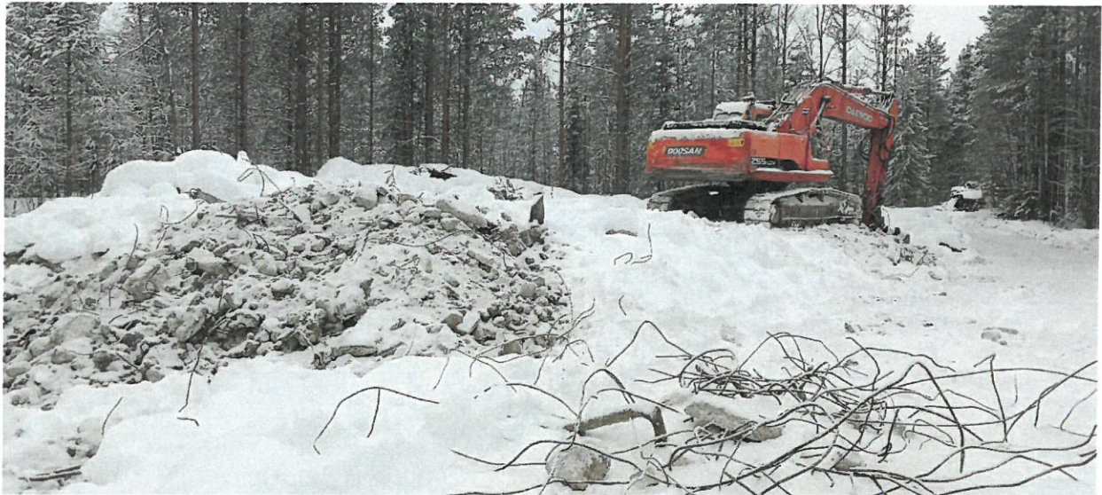
Kuva 2. Purkubetonista eroteltua metalliromua.
